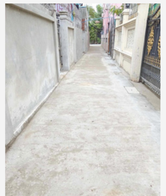
水道修理後の道
