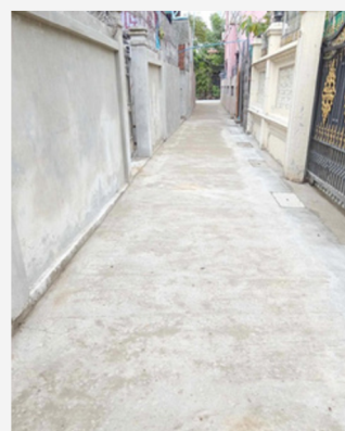
水道修理後の道
