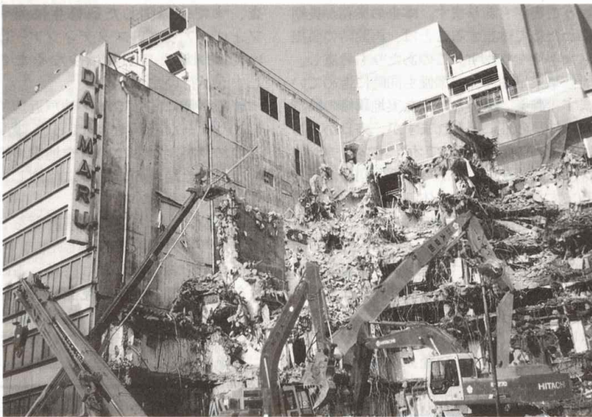
PHD協会事務所周辺のビル解体作業現場
