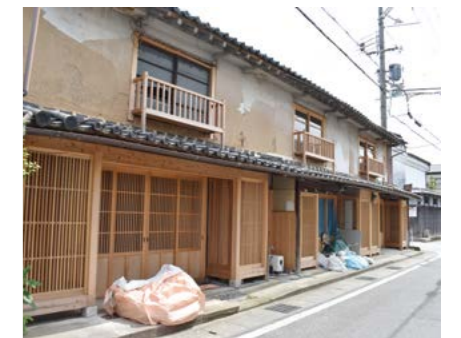
改装中の店舗「川原町三軒長屋」(2019年6月撮影)
