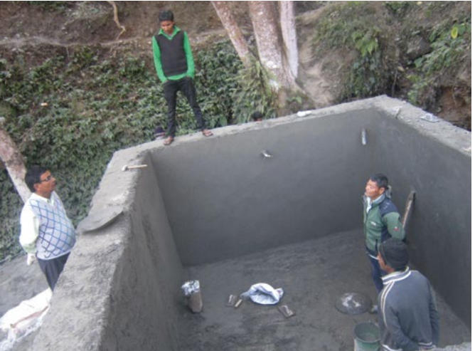
ガハテ村にて簡易水道のタンクを設置
