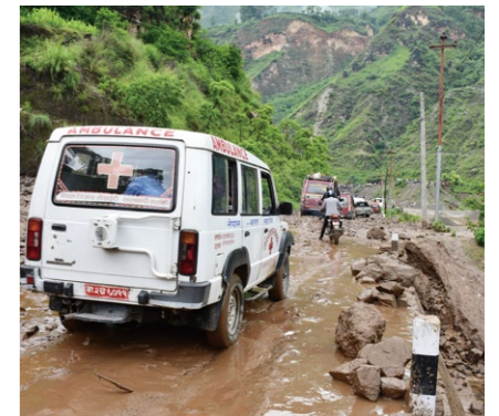
2018年夏のネパール出張中に遭遇した土砂崩れ。雨期とはいえ、現地の人が驚くほどの雨が短時間に降り、土砂崩れが私たちの車両の前後両方で発生しました。しかし、日本のように通行止めになることもなく、危険な状況の道路を進むことになりました。
