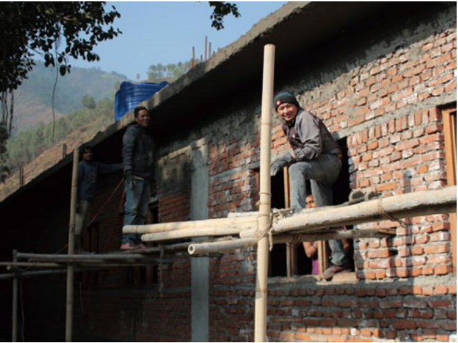
建設中の新しい校舎（ジャナビジャヤ小学校）
